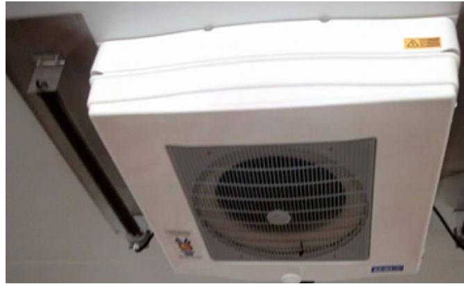
Les réglages pour le saucisson sec sont donnés pour la température de 11 à 15 °C, une hygrométrie de 72 à 85 % et une vitesse de l'aire de 0,05 à 0,1 m/s au niveau des saucissons.
